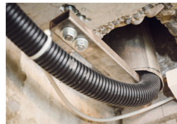
L'ancien conduit de cheminée sert aujourd'hui au passage des câbles pour l'installation solaire.
