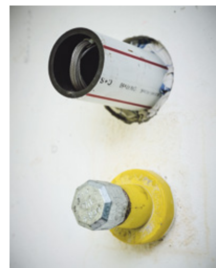
Le raccord de gaz abandonné (ci-dessous) et la conduite d'alimentation prête pour la borne de recharge électrique.
