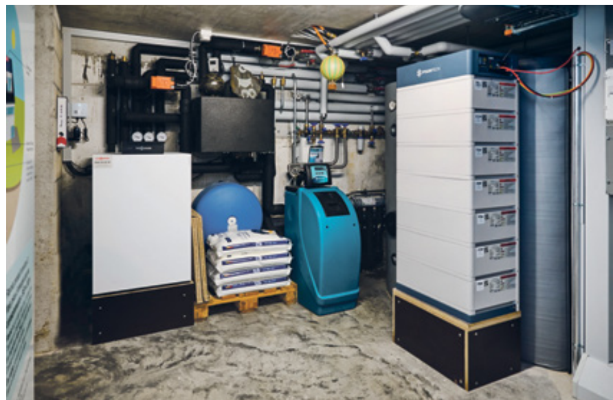
Le local technique est au sous-sol, où sont installés la pompe à chaleur et l'accumulateur d'électricité et de chaleur.
