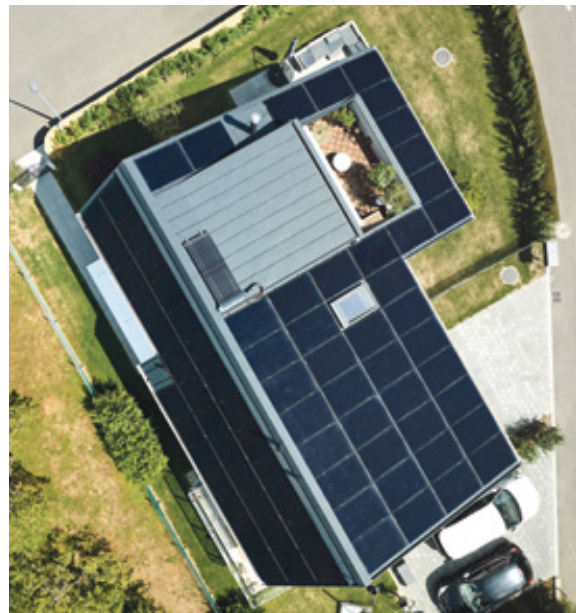
Le toit est équipé de cellules photovoltaïques et d'une installation solaire thermique.
