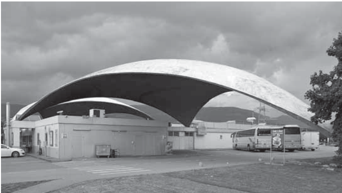
Abbildung 54: Die Betonschalenskonstruktion des Bauingenieurs Heinz Isler (oben) und das «Palazzo della Civiltà del Lavoro» in Rom (unten) sind Beispiele für einfache Tragkonstruktionen.
