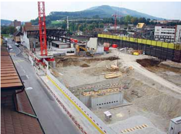
Abbildung 64: Bau der Versickerungsanlage für den Neubau der Fachhochschule Nordwestschweiz in Olten. Im Hinblick auf Erweiterungsmöglichkeiten wurde Kapazität des Brunnens für die Versorgung einer zweiten Baustappe ausgelegt.
