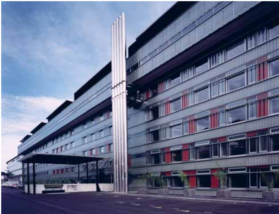
Abbildung 63: Aussenansicht Bundesamt für Statistik in Neuen-burg (Foto: Ruedi Walti).
