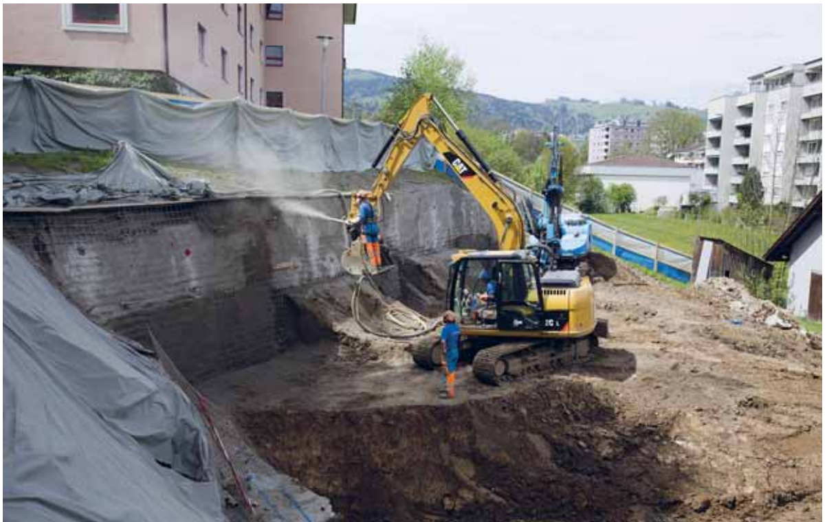
Abbildung 96: Baugrube des MFH Kirchrainweg mit abgetreppter Sole zur Reduktion des Aushubvolumens (Foto: aardeplan).
