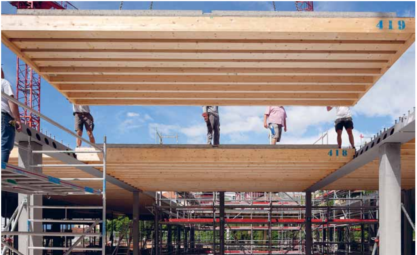
Abbildung 58: Einbau der vorgefertigten Holz-Beton-Verbundelemente. Die Vorfabrikation verkürzt die Bauzeit erheblich und das Konstruktionsprinzip reduziert die graue Energie.
