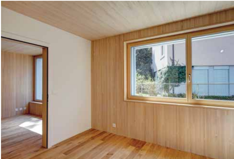
Abbildung 117: Im Edelrohbaus sind die tragenden Blockholzplatten der Aussenwände und Decken im Innern sichtbar (Foto: Aura Fotoagentur).
