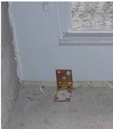
Abbildung 78: Typische Anwendung von Montage- und Füllschaum (Fotos: Stadt Zürich, Amt für Hochbauten).
