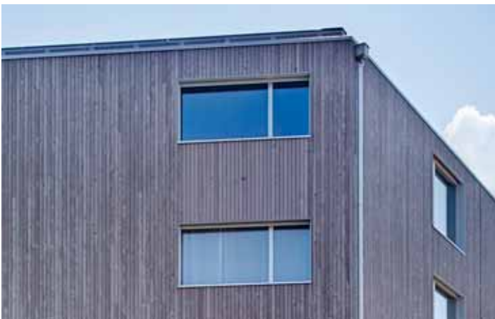
Abbildung 107: Die Fassade des MFH Kirchrainweg als Blockholzkonstruktion mit Holzfasade (Foto: Aura Fotoagentur).
