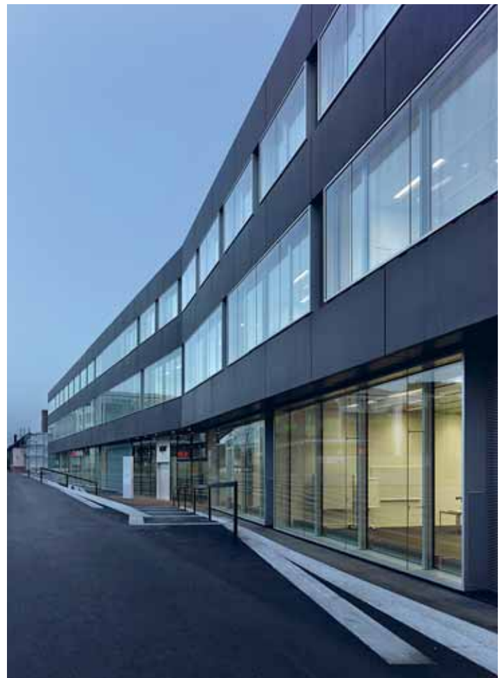
Abbildung 67: FHNW Olten – Fassadenansicht (Foto: Alexander Gempeler).
