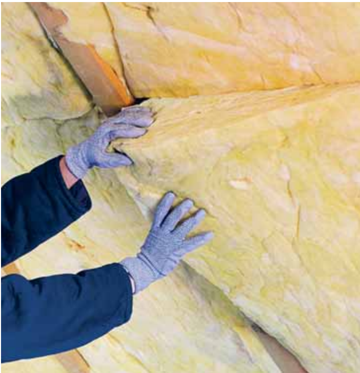
Abbildung 113: Steildachdämmung zwischen den Sparren ermöglicht die Wahl eines Wärmedämmstoffes mit geringer Dichte (Foto: Fotolia).
